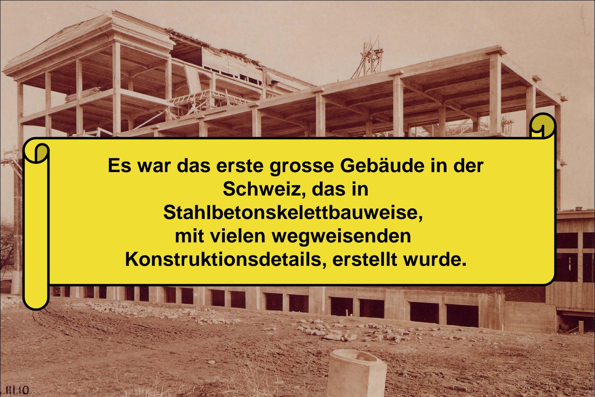
**Es war das erste grosse Gebäude in der Schweiz, das in Stahlbetonskelettbauweise, mit vielen wegweisenden Konstruktionsdetails, erstellt wurde.**
